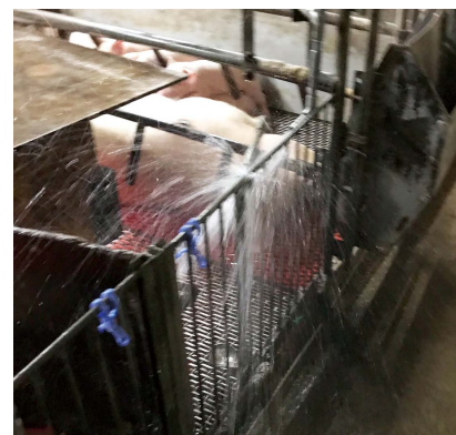
水漏れが発生している様子
